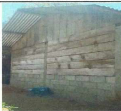
Foto 2: Mejoramiento de estructura de madera por metal.
