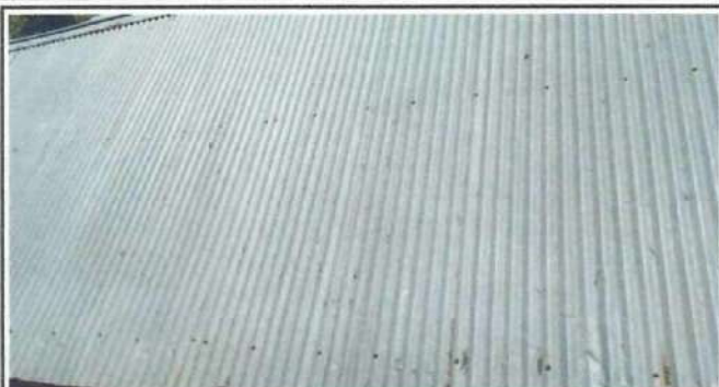
Foto1: Sustitución de lámina acanaleada en mal estado por lámina troquelada calibre 26.
